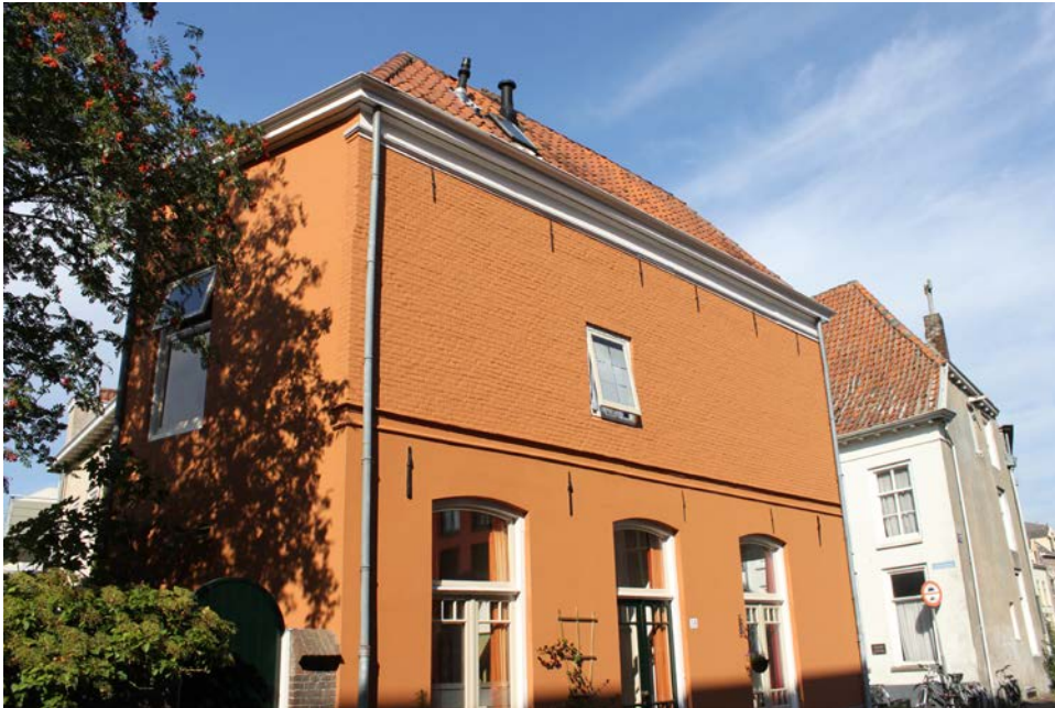
Foto: Silicaatlagen blijven jaren stabiel van kleur.
