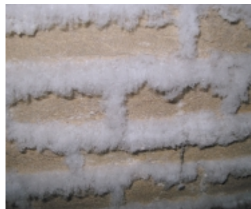
Zoutuitbloei op in goede staat verkerend 19de eeuws kalkvoegwerk. Door de open structuur van de kalkmortel kunnen vocht en zouten vrij naar buiten treden zonder dat daarbij schade ontstaat. (foto Erik Jan Brans)
