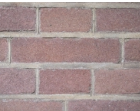
Mooi en in goede staat verkerend kalkvoegwerk van een door Berlage ontworpen villa uit 1885 te Lochem
