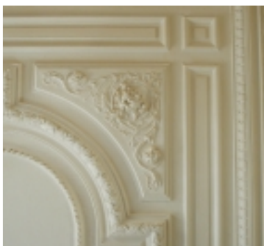
Toepassing van gips-kalkmortel. Een rijk 19de eeuwse stucplafond met gietwerk en getrokken lijst. Het kalkaandeel is van oudsher in de rot gezette luchtkalk
